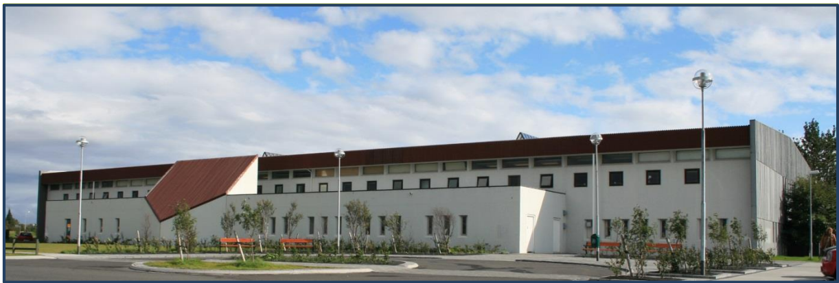
Aðalbygging Garðaskóla. Húsið er teiknað af Manfred Vilhjálmsyni arkitekt.
